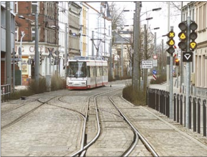
Spårvägens och järnvägens spårvidd måste överensstämna, om inte tre- eller flerskensspår anläggs, som här Zwickau i Tyskland. Stadsspårvägen är meterspårig...
