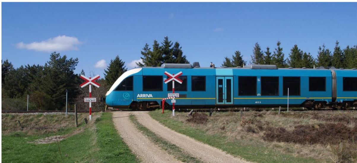
Figur 14.2 Privat usikret overkørsel ved Borris udstyret med afmærkning og led. Denne sikring er tilstrækkelig ved strækningshastighed på indtil 100 km/t, men skal sikres med blinklys ved hastighed på 120 km/t og bomanlæg ved 140 km/t.
