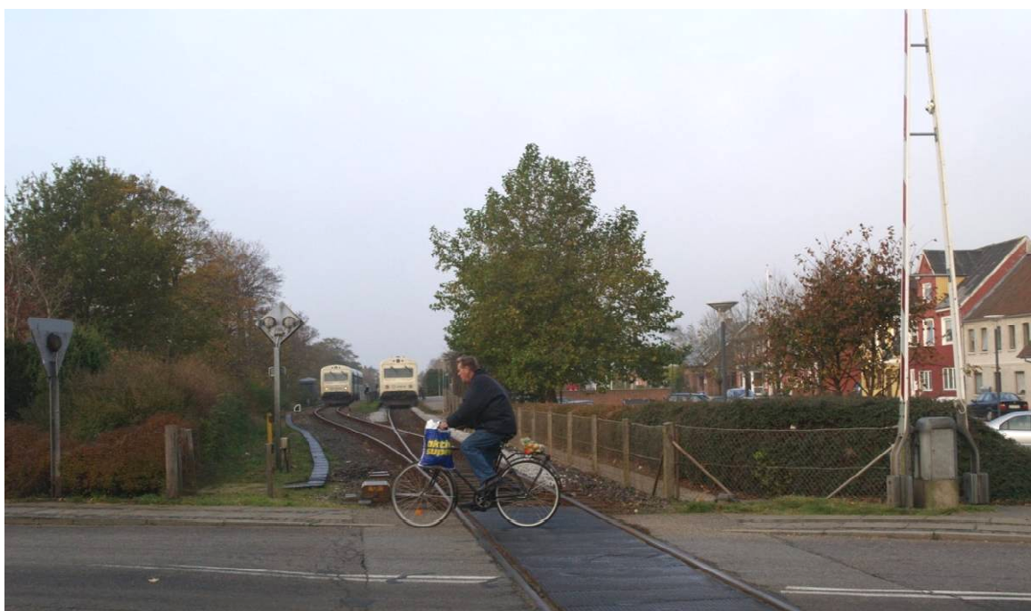
Figur 14.1 Togkrydsning i Kibæk med tilstødende overkørsel med bomanlæg på strækningen Herring-Skjern.
