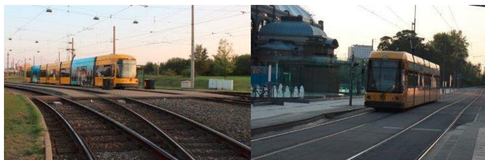
Figur 6: Eksempel på ballasteret spor og rillespor
